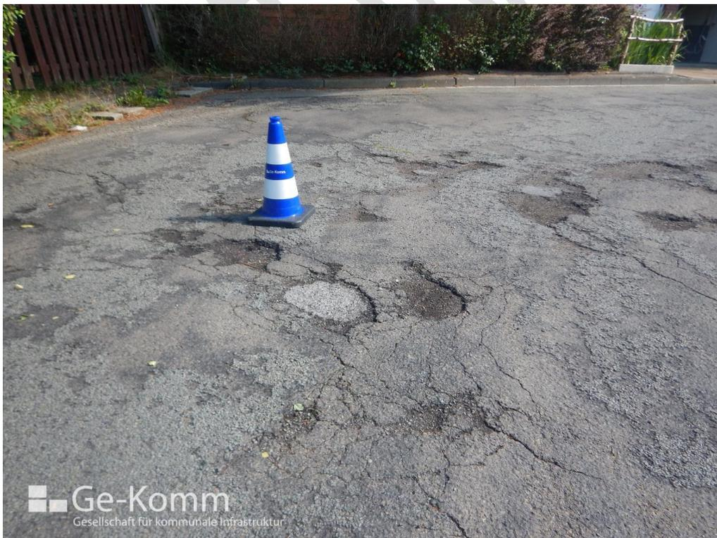
Abbildung 15: Starke Oberflächenschäden mit Ausbrüchen, Quelle: Ge-Komm GmbH
