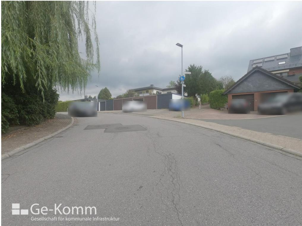
*Abbildung 24: Deutliche Risse im mittleren Bereich und am Rand der Fahrbahn, MK2, Quelle: Ge-Komm GmbH*
