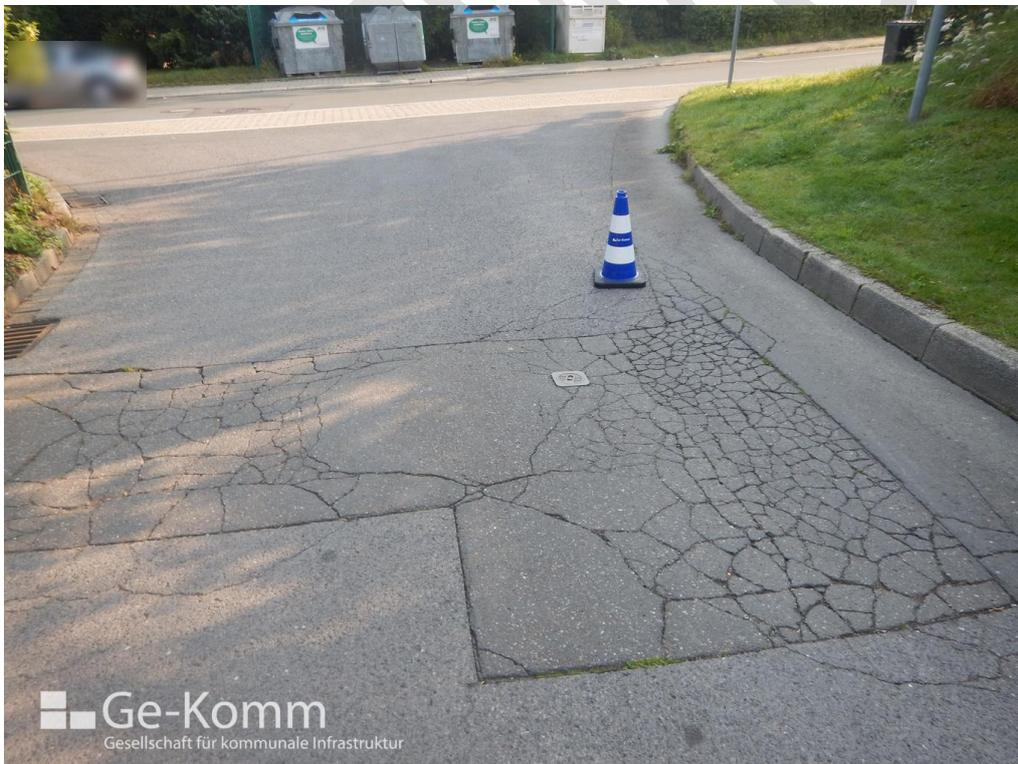
*Abbildung 17: Nicht fachgerecht ausgeführte Flickstelle als Ursache für deutliche Netzrisse und Unebenheiten, Quelle: Ge-Komm GmbH*
