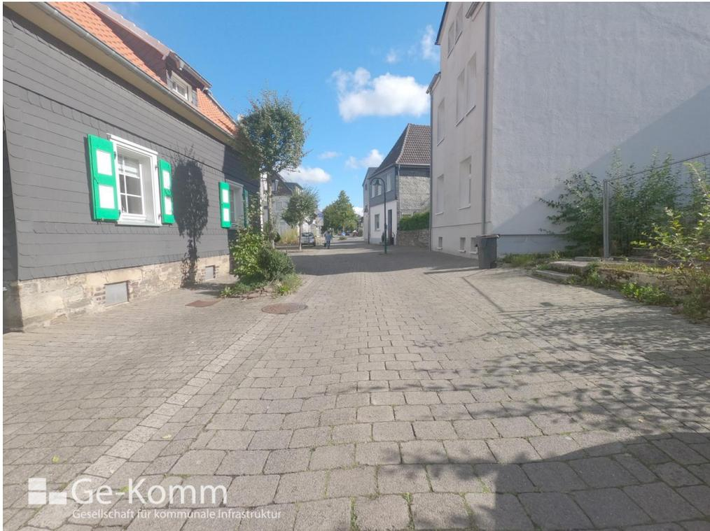
*Abbildung 26: Deutliche Spurrinnen und offene Pflasterfugen, MK-4, Quelle Ge-Komm GmbH*
