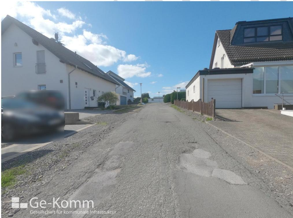
*Abbildung 27: Sehr starke Unebenheiten und Ausbrüche in der Fahrbahn, MK-5, Quelle: Ge-Komm GmbH*
