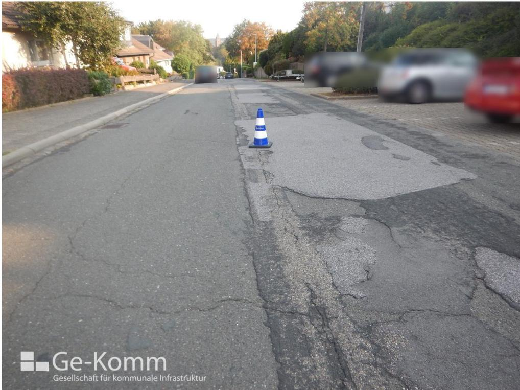
*Abbildung 16: Risse, Flickstellen und Oberflächenschäden am Hansering, Quelle: Ge-Komm GmbH*
