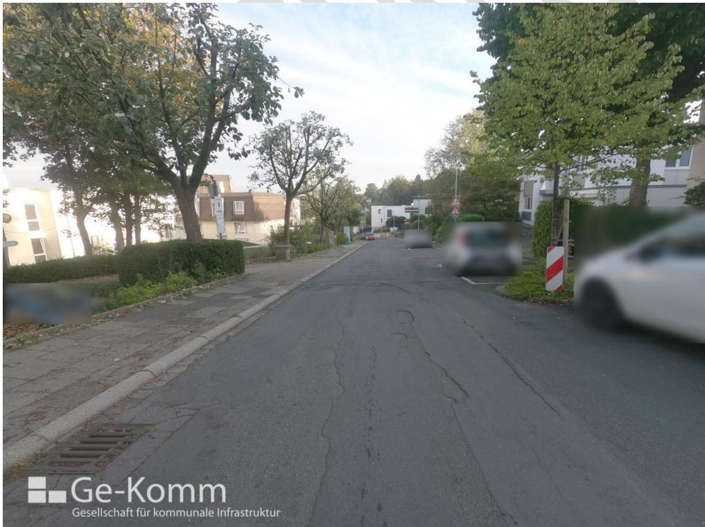
*Abbildung 25: Fahrbahn mit Netzzissen, Unebenheiten und Ausbrüchen, MK-3, Quelle: Ge-Komm GmbH*
