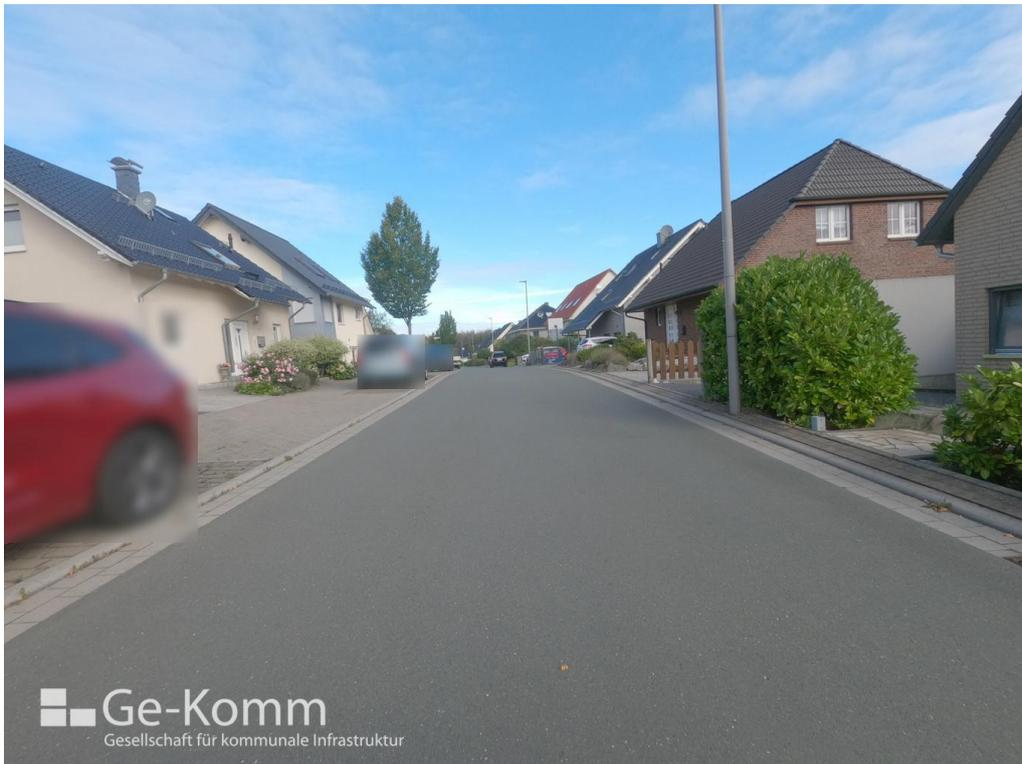
*Abbildung 22: Fahrbahn ohne nennenswerte Schäden, MK-0, Quelle: Ge-Komm GmbH*
